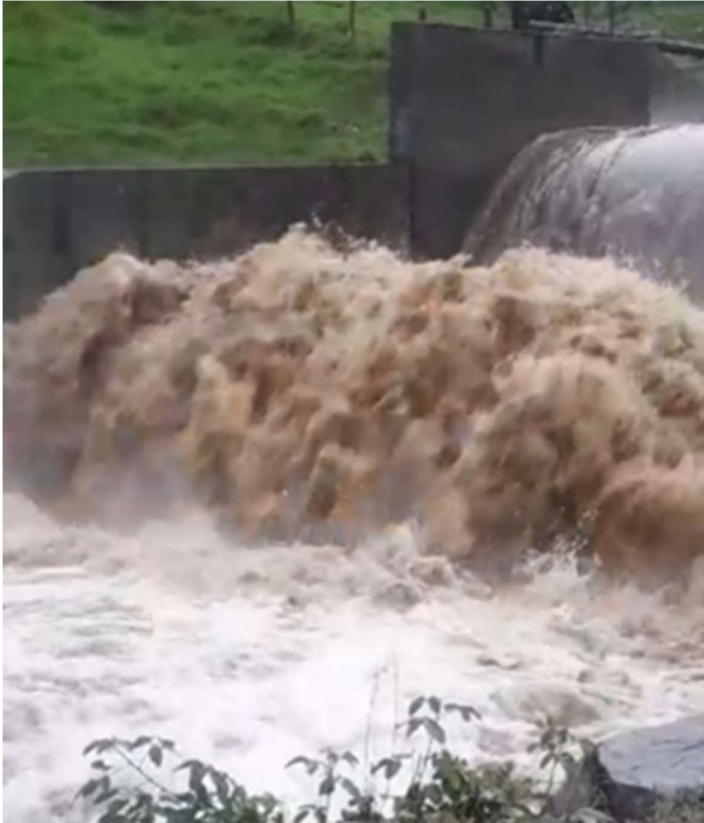
Captación en el río Pampa de San Miguel, en temporadas de lluvias intensas.
