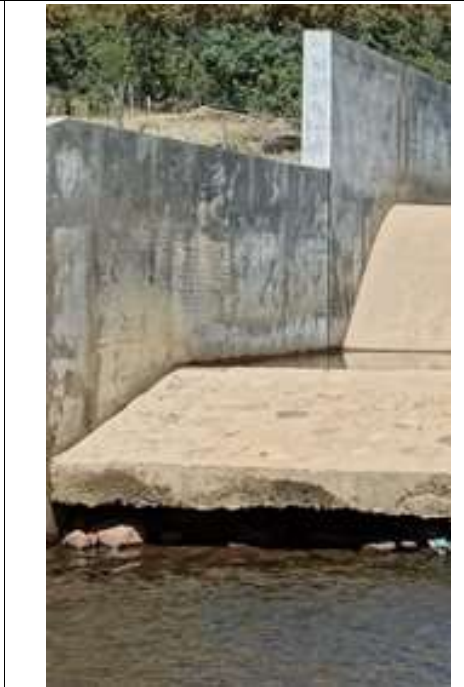
Cámara de rejas atorada por basura y vegetales, impide la captación del agua. Colchón de aliviadero se está destruyendo por socavación. 2024
