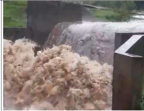
Cámara de rejas atorada por basura y vegetales, impide la captación del agua. Colchón de aliviadero se está destruyendo por socavación. 2024
