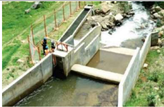
Cámara de rejas atorada por basura y vegetales, impide la captación del agua. Colchón de aliviadero se está destruyendo por socavación. 2024
