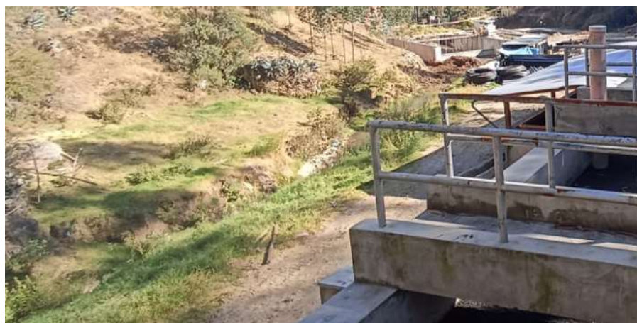
Rio que sirve como cuerpo receptor de las aguas tratadas de la PTAR Contumazá, el rio tiene muro de protección y las estructuras de saneamiento están muy cerca al rio.
