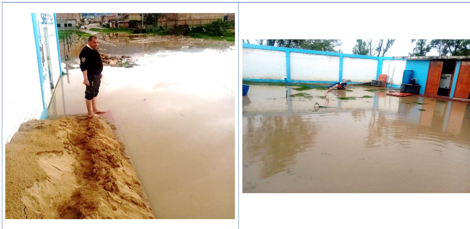
Inundación en la calle de ingreso a la cámara de bombeo de aguas residuales de Ajoscancha e inundación al interior de la cámara de bombeo de aguas residuales.
