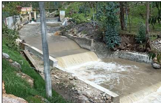
Remodelación de la captación Porcón - febrero 2023
