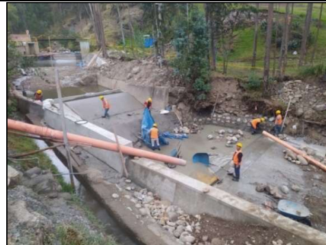
Remodelación de captación noviembre 2022
