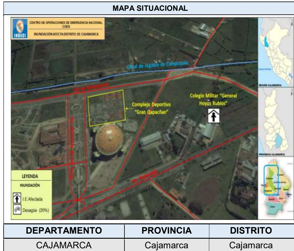
Figura N° 2. Registro de inundación en el distrito de Cajamarca. Informe N° 307 – 17/03/2016 Fuente: Centro de Operaciones de Emergencia Nacional (COEN) – INDECI.
