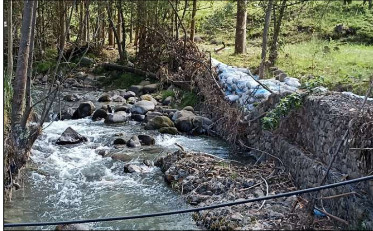
Zona probable de desborde del río Grande, inundando la instalación de la captación río Grande
