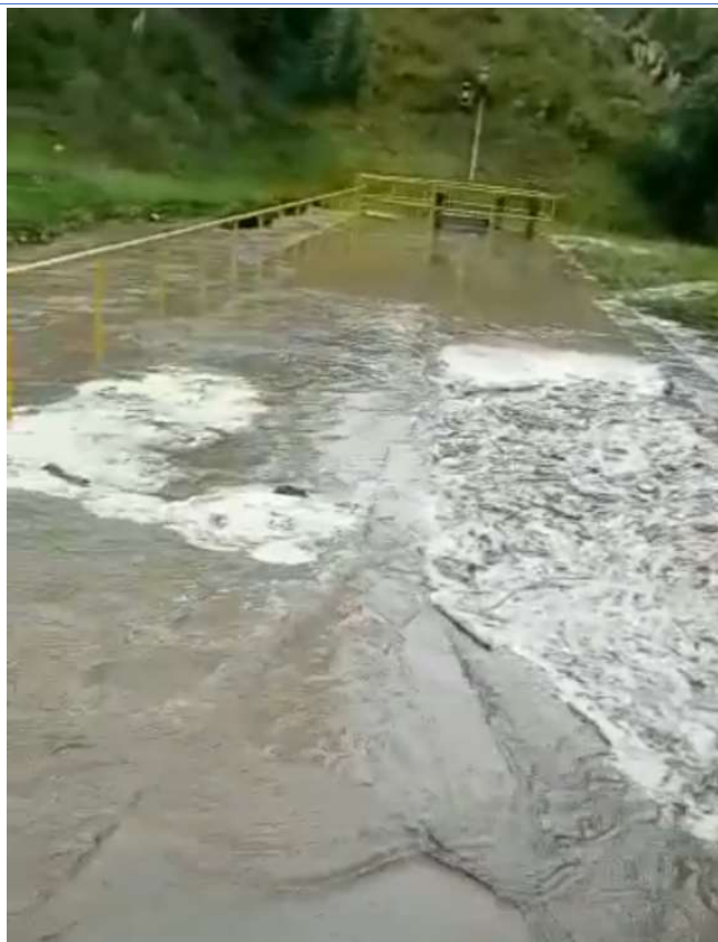
Inundación en los desarenadores en la captación río Grande e inundación en la captación río Porcon.
