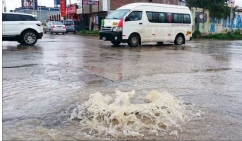
Inicio de la temporada de lluvias, e inunda el sistema de alcantarillado en la parte baja de la ciudad.
